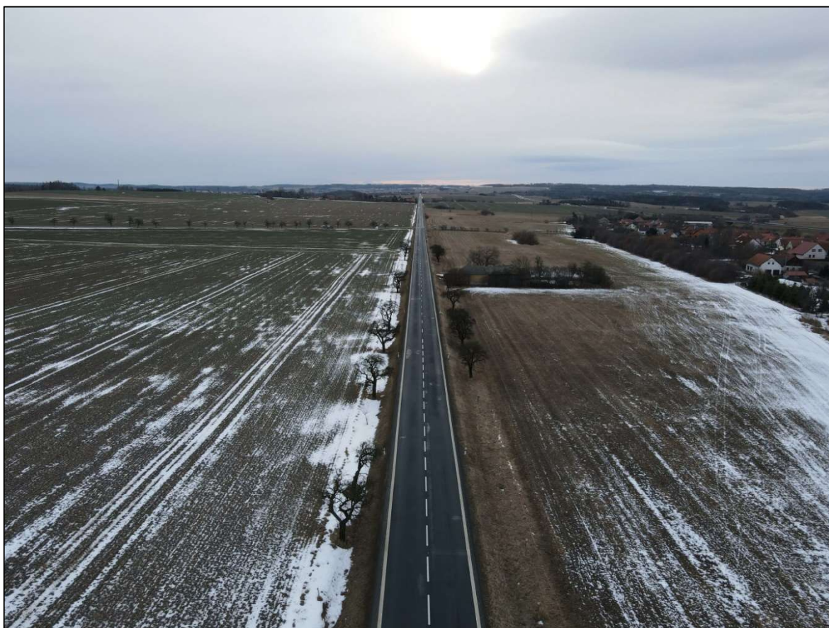
Obr.: pohled po trase II/602 u zastavby Jáchymova
