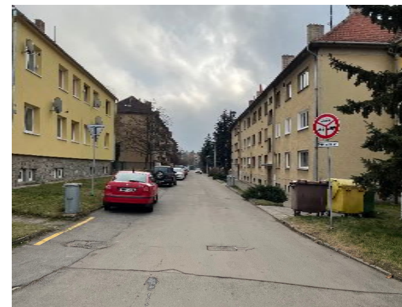
Příklad nekvalitně provedených asfaltových povrchů. [ ulice Na Výsluní ]
