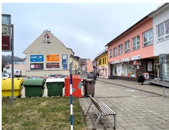
Nevhodné provedení chodníků i parkovacích ploch v centru města. [ ul. Radnická ]
