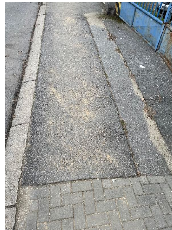
Při provádění veřejných přípojek by mělo být postupováno na základě jednotných pravidel – uvedení chodníku do původního stavu vč. přeasfaltování v celé délce přípojky. [ Velké Meziříčí ]
