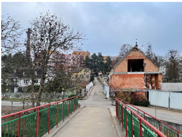
Nevhodná barevnost I provedení mostu v centru města. [ ul. Hřbitovní ]
