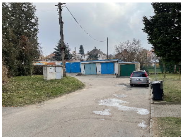
U některých ulic v obytné části města je absence chodníků. [ ulice Na Výsluní ]
