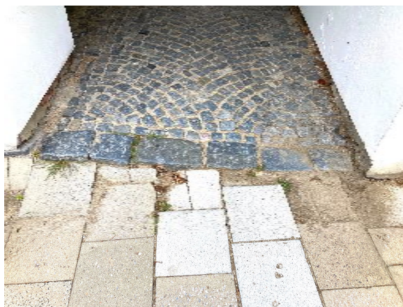
Špatné technické provedení, řešení detailu rozhraní I nevhodný materiál chodníků. [ centrum města ]
