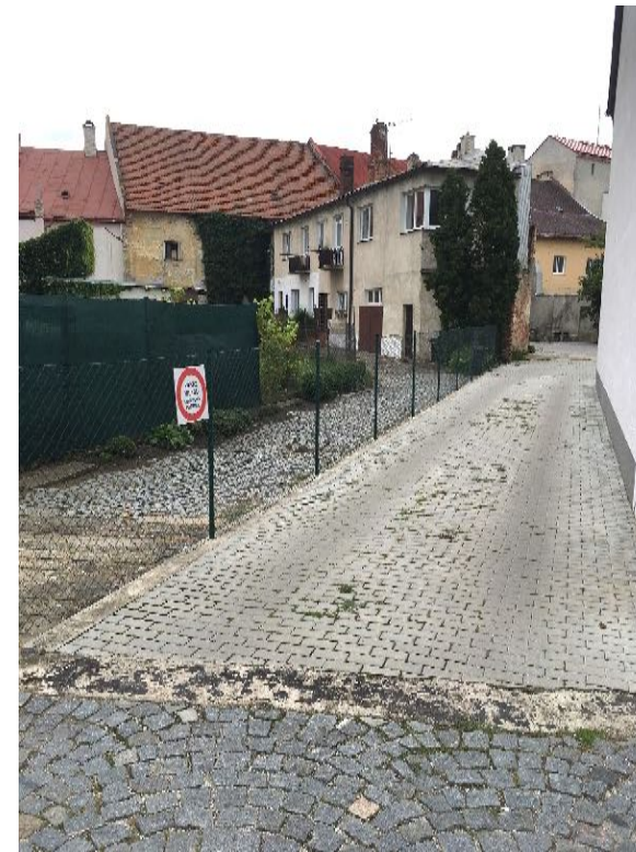
Nesprávné provedení detailu návaznosti různých materiálů. [ centrum města ]
