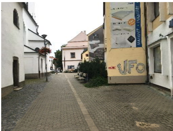
Nevhodná kombinace kamenné a betonové dlažby v městské památkové rezervaci. [ prostor okolo kostela sv. Mikuláše ]
