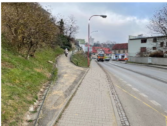
Nevhodná volba materiálů pro pěší přístup na zámek. [ ul. Hornoměstská ]
