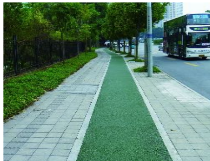
&lt; Probarvený asfalt
