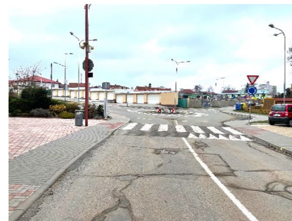
Minimálně pět různých barevných odstínů a různých typů betonových dlažeb, použitých na jednom místě. Esteticky necitlivé řešení kruhového objezdu. [ ul. Oslavická ]
