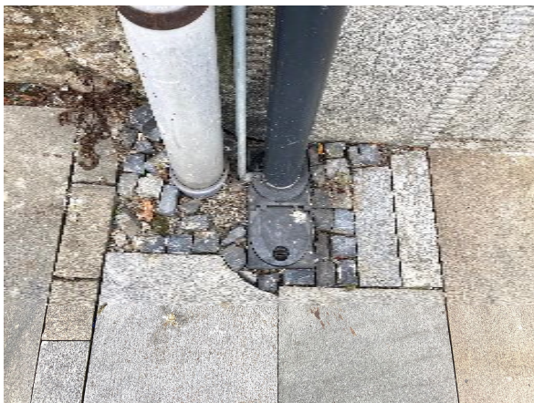
Nevhodné provedení detailu okolo dešťového svodu. [Náněstí]
