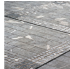
ŽULOVÁ DLAŽBA Z TMAVÝCH KOSTEK hlavní plocha náměstí - 2 různé formáty a odstíny
